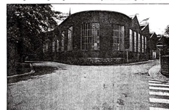
La démolition des anciens Ateliers Kihn est le premier projet à réaliser dans le cadre du projet Objectif Plein Emploi.
