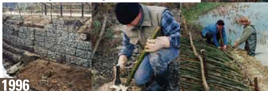
Sécurisation des verges de la Chiers, Pétange.
